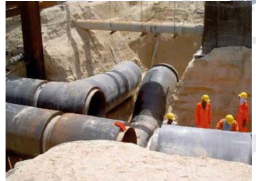
Távhűtési elosztóhálózat telepítése Dubaiban
